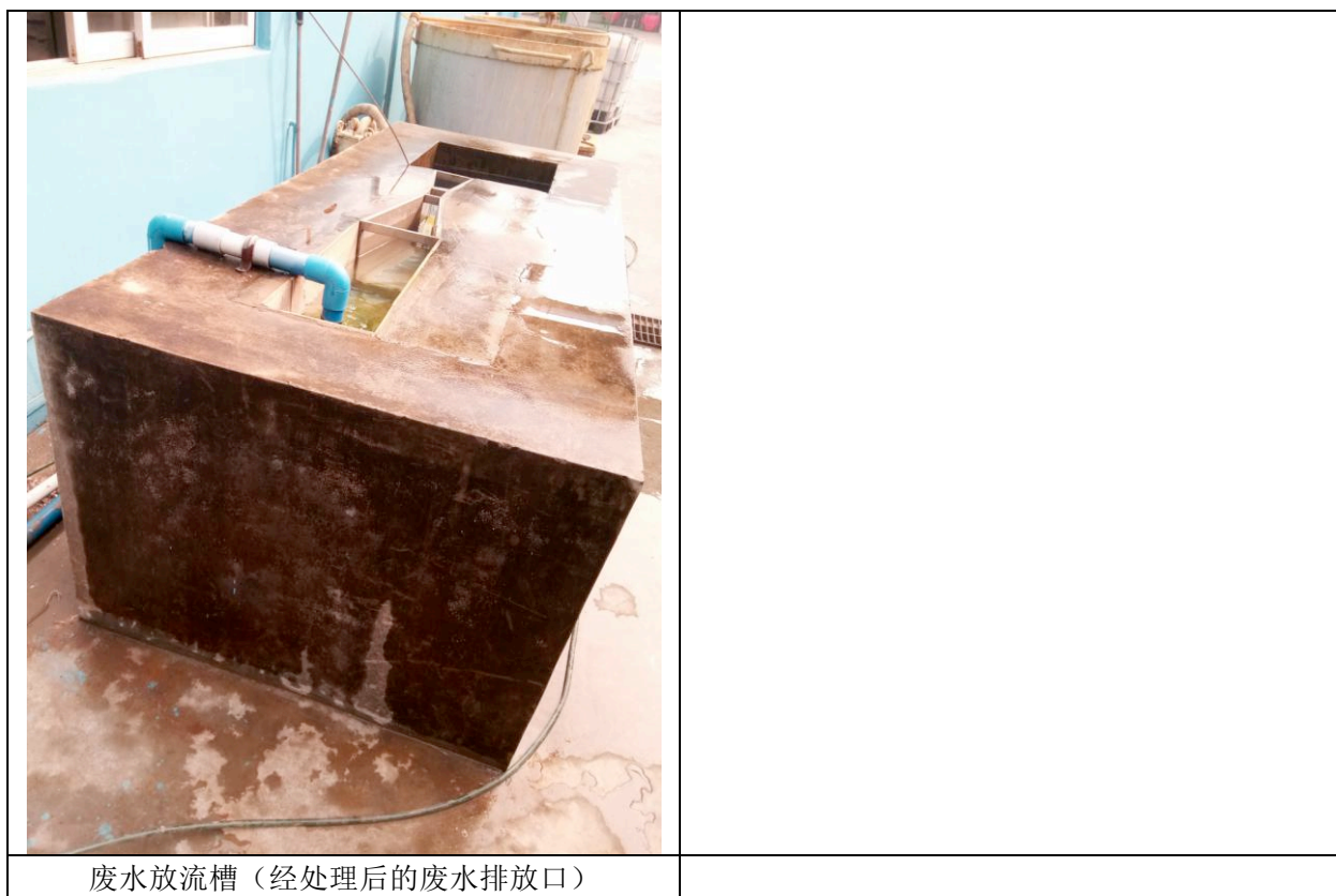
图 4.1-2 广东华润涂料有限公司废水处理设施照片
