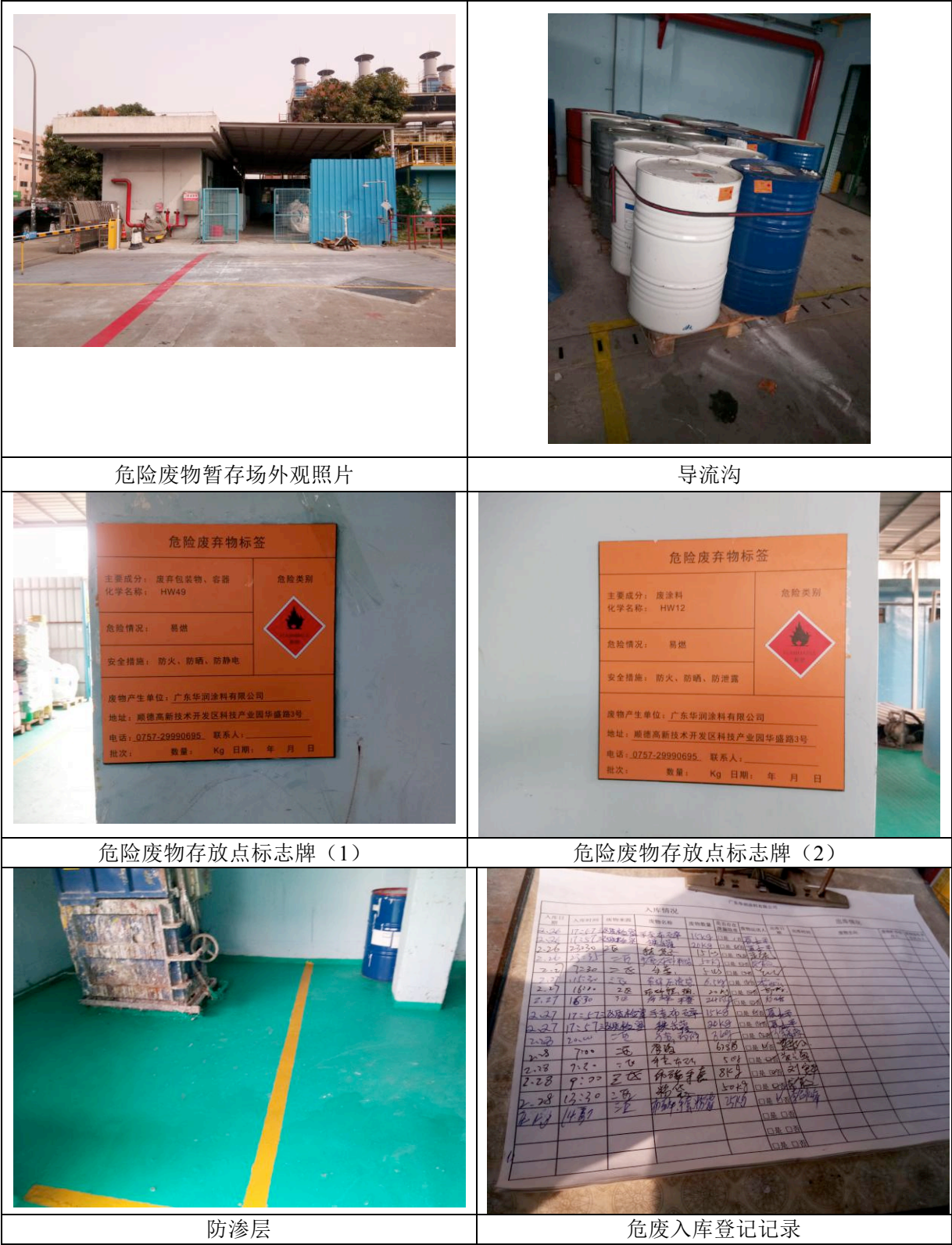
图 4.1-7 固体废物存放点照片
