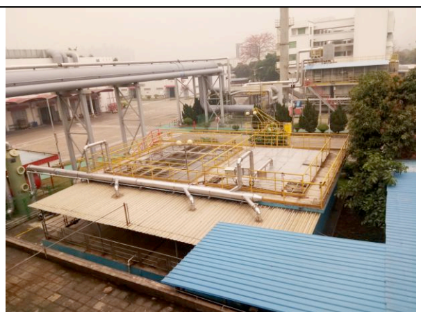
厂区废水处理站 2
