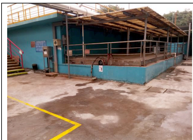
厂区废水处理站 1
